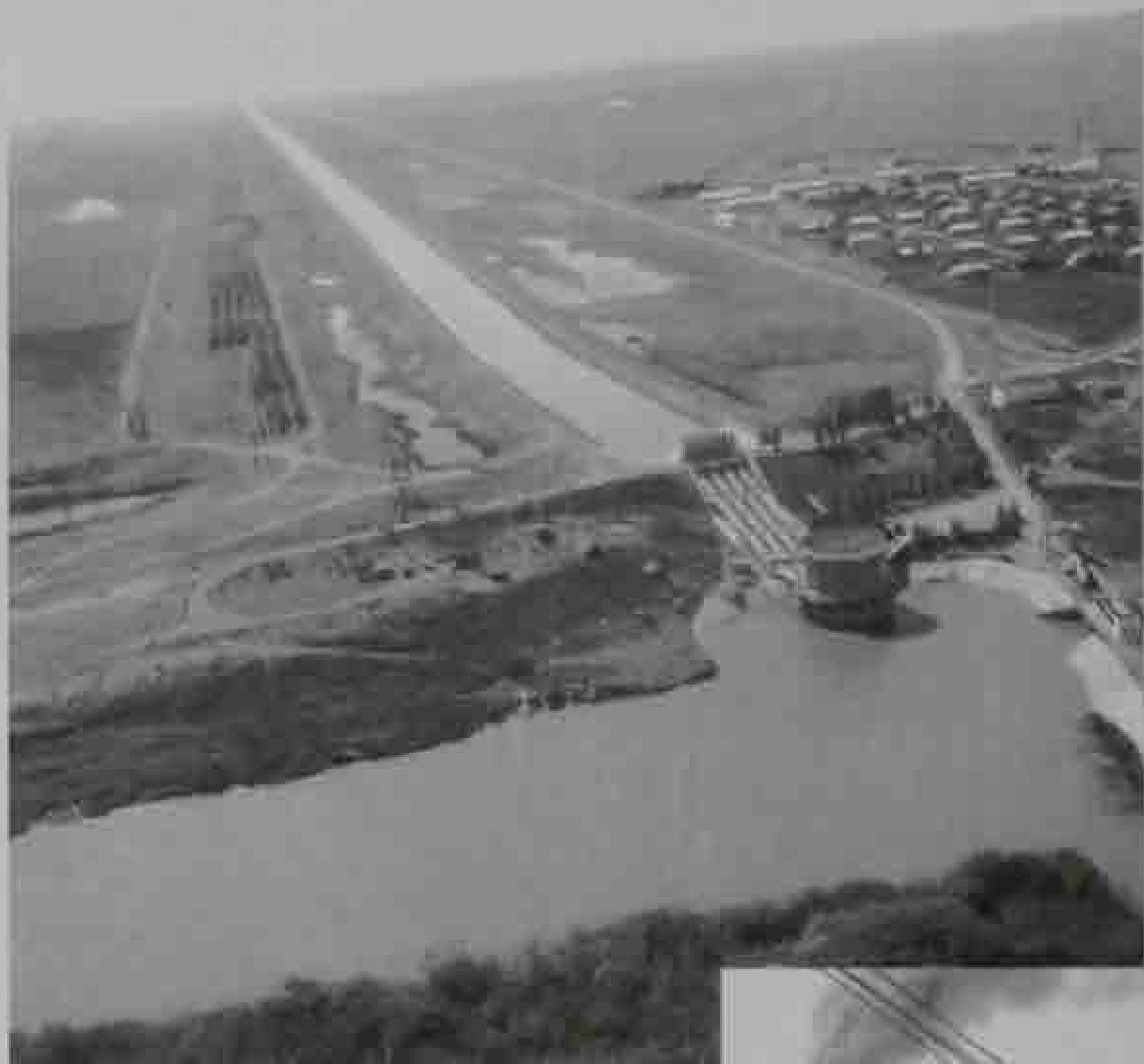
Канал Иртыш-Караганда. Головная насосная станция.
