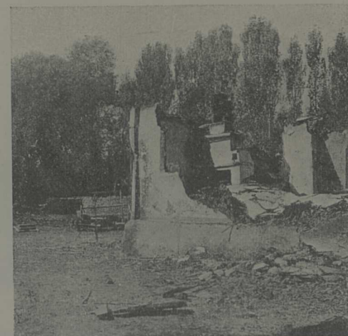
1916 г. Ликвидация восстания в Семиречьи. Разрушенный кишлак
